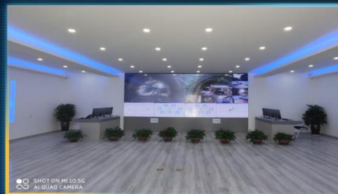
梁王山隧道值班室
