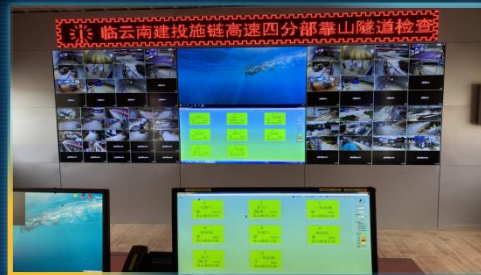
小燕塘隧道监控点位安装
