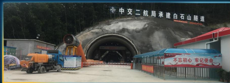
中交二航局隧道
