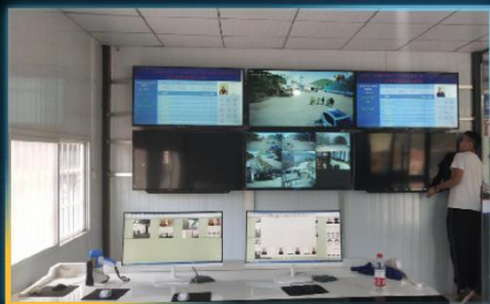
长村隧道值班室
