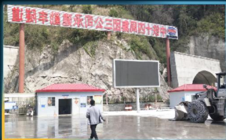
大伍龙莫隧道值班室操作台
