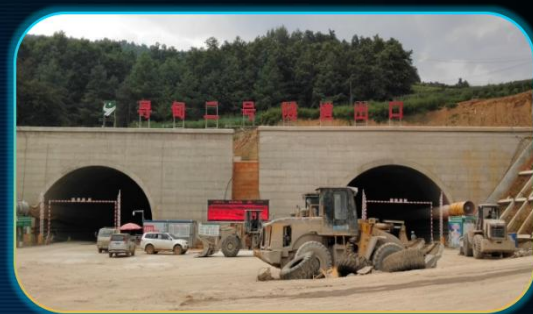
武尚寻高速－寻甸二号隧道
